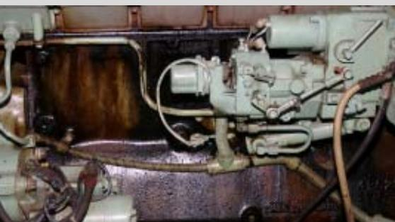
*Diesel vaza do gerador de Emergência.*
