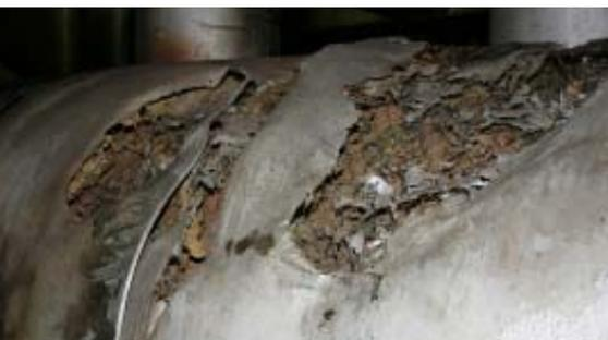
*Isolamento térmico do duto de descarga de gases do MCP necessitam de substituição; estado de conservação precário.*
